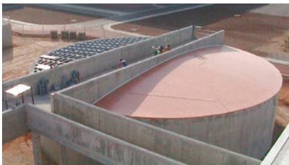
Cubierta circular plana
