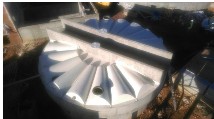
Cubierta circular ondulante
