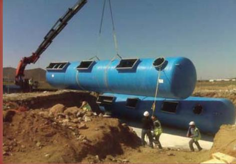
Tanques horizontales para enterrar, fabricados en PRFV con los dos fondos toriesféricos y aros de refuerzo en PRFV.
